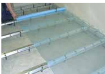
Instalación flotante de 22 mm de aglomerado
